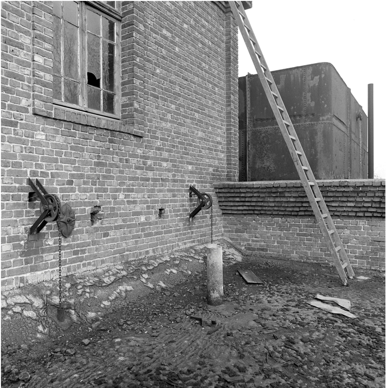
Pièce de séchage dite séchoir au feu (D). Mécanisme d'ouverture des cheminées.
