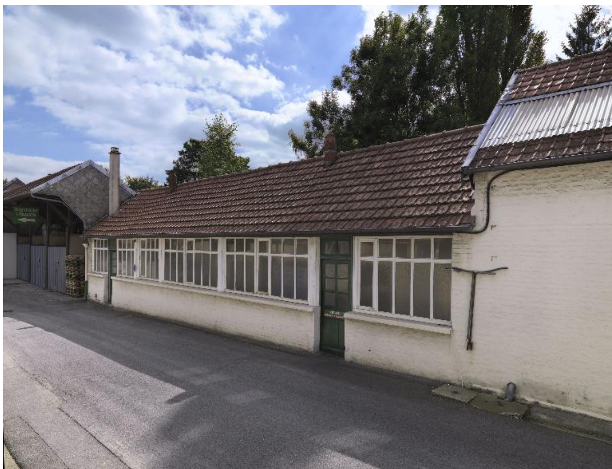
Anciens ateliers de fabrication, aujourd'hui vestiaires.
