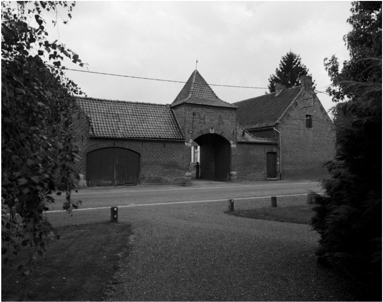
Vue générale de la ferme de face depuis la rue.
