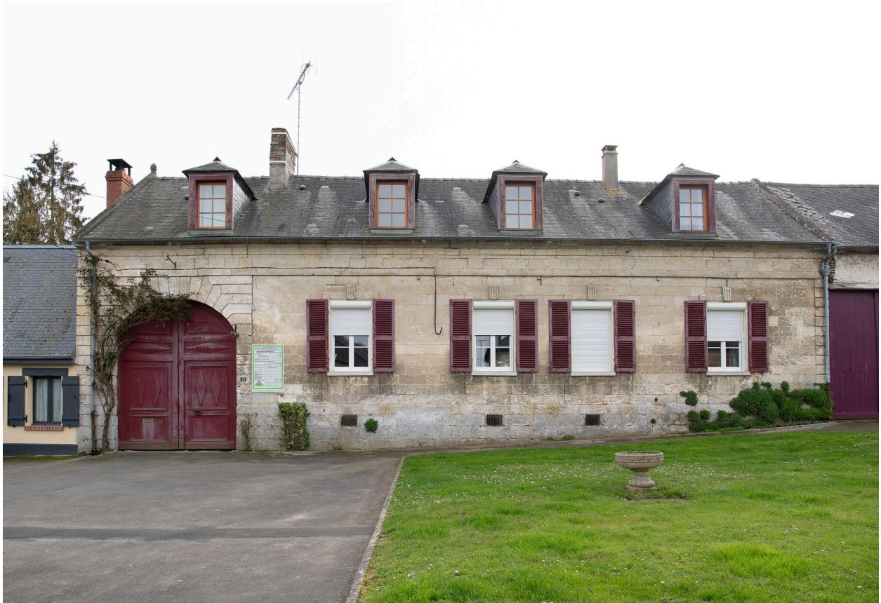
Demeure en pierre, n°16 de la rue de la Ville, vue prise depuis le nord.
