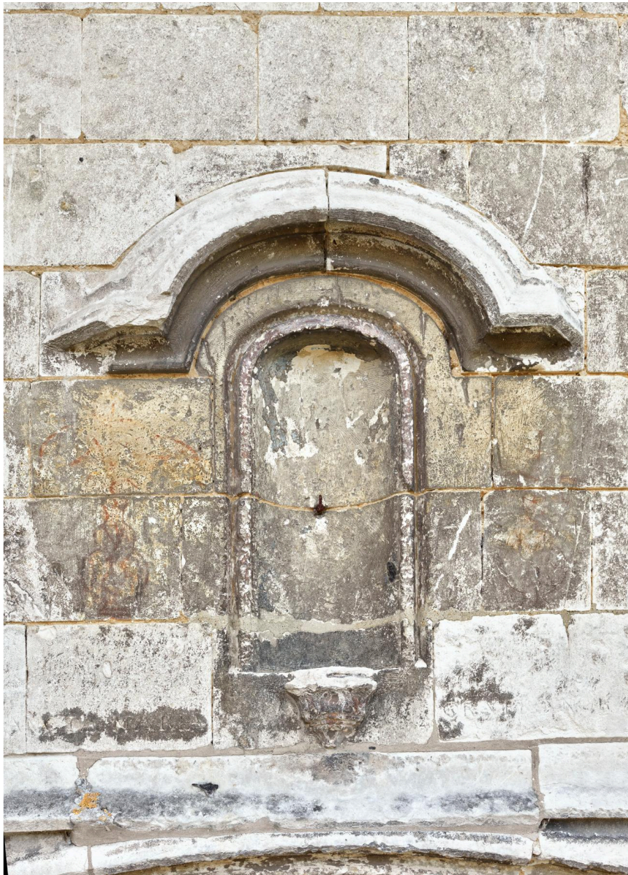
Détail de la niche surmontant le portail latéral nord.
