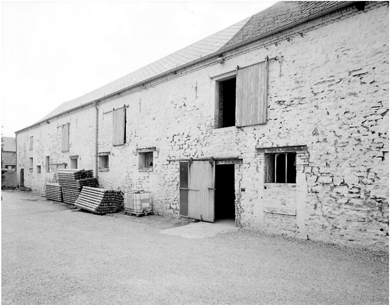
Vue des étables-fenil depuis la cour.
