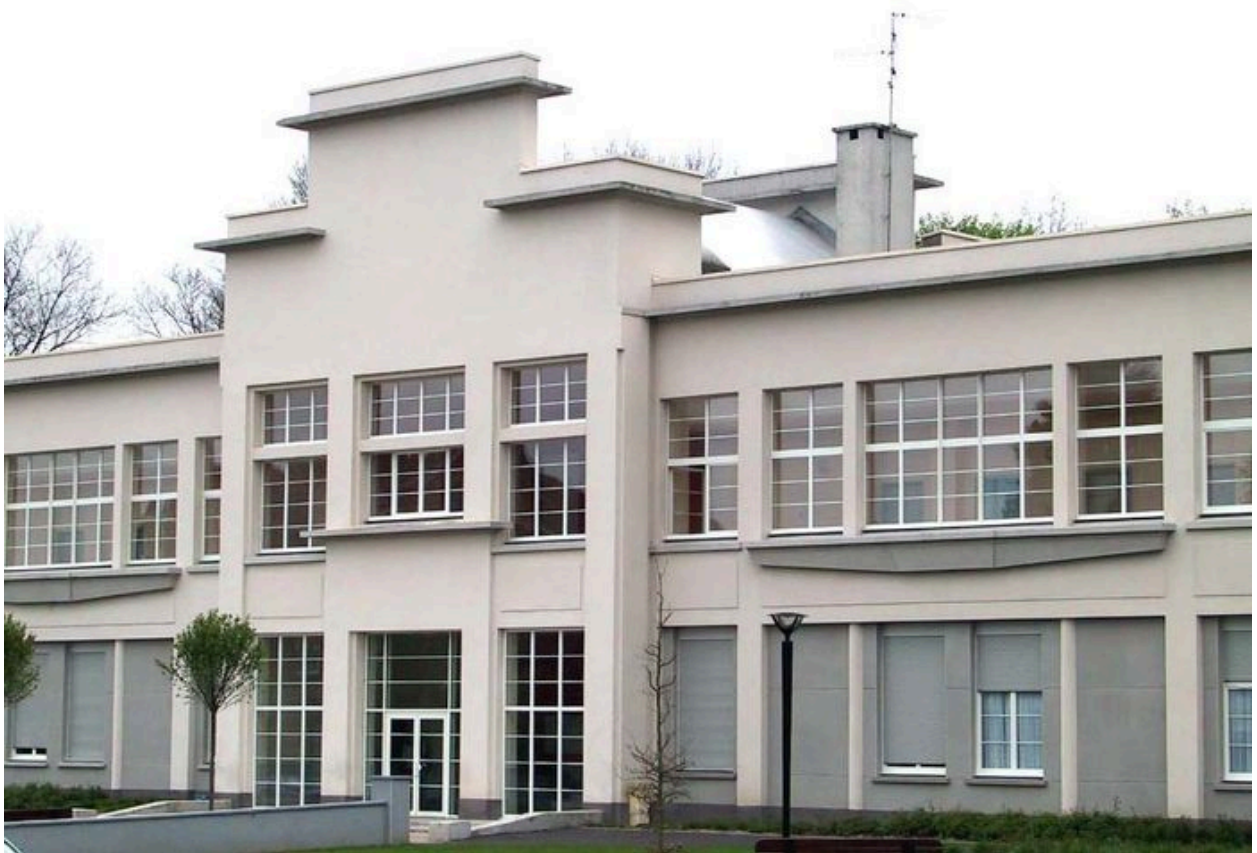
Façade principale, vue partielle, état en 2005.
