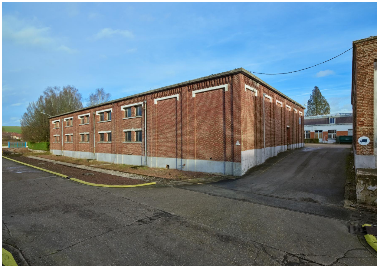
Vue d'ensemble nord-ouest des entrepôts (batiment E).
