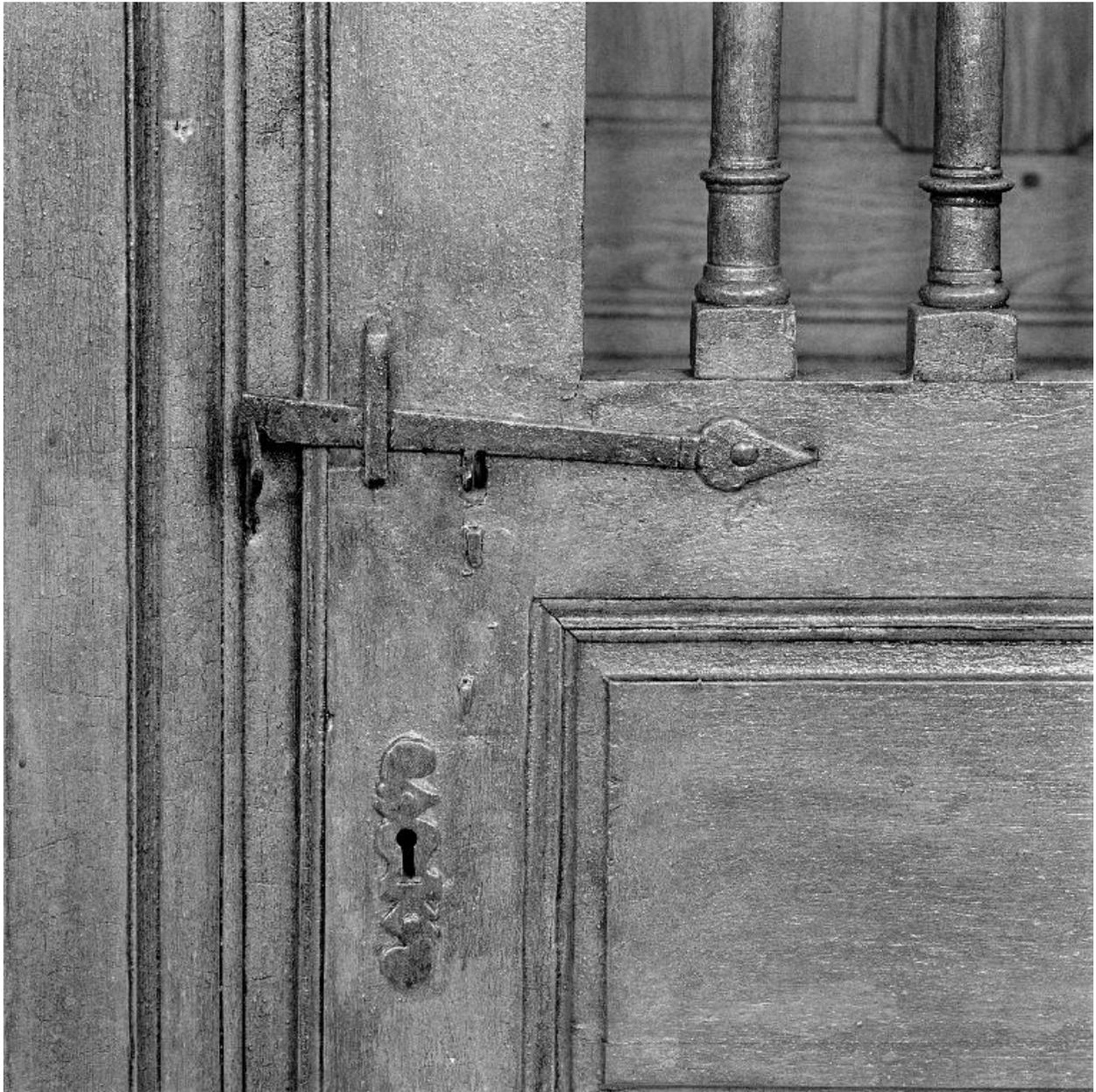
Détail de la fermeture de la porte : la clenche du loquet et la platine de la serrure.
