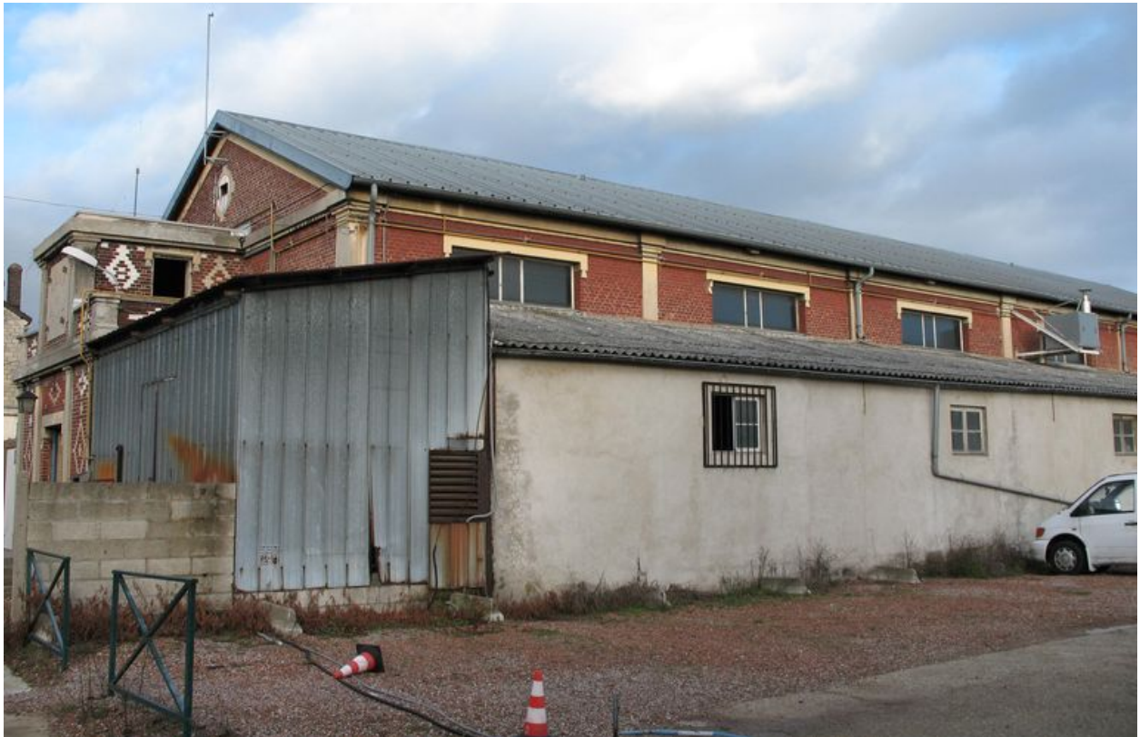
Mur sud et entrée de la salle des fêtes.
