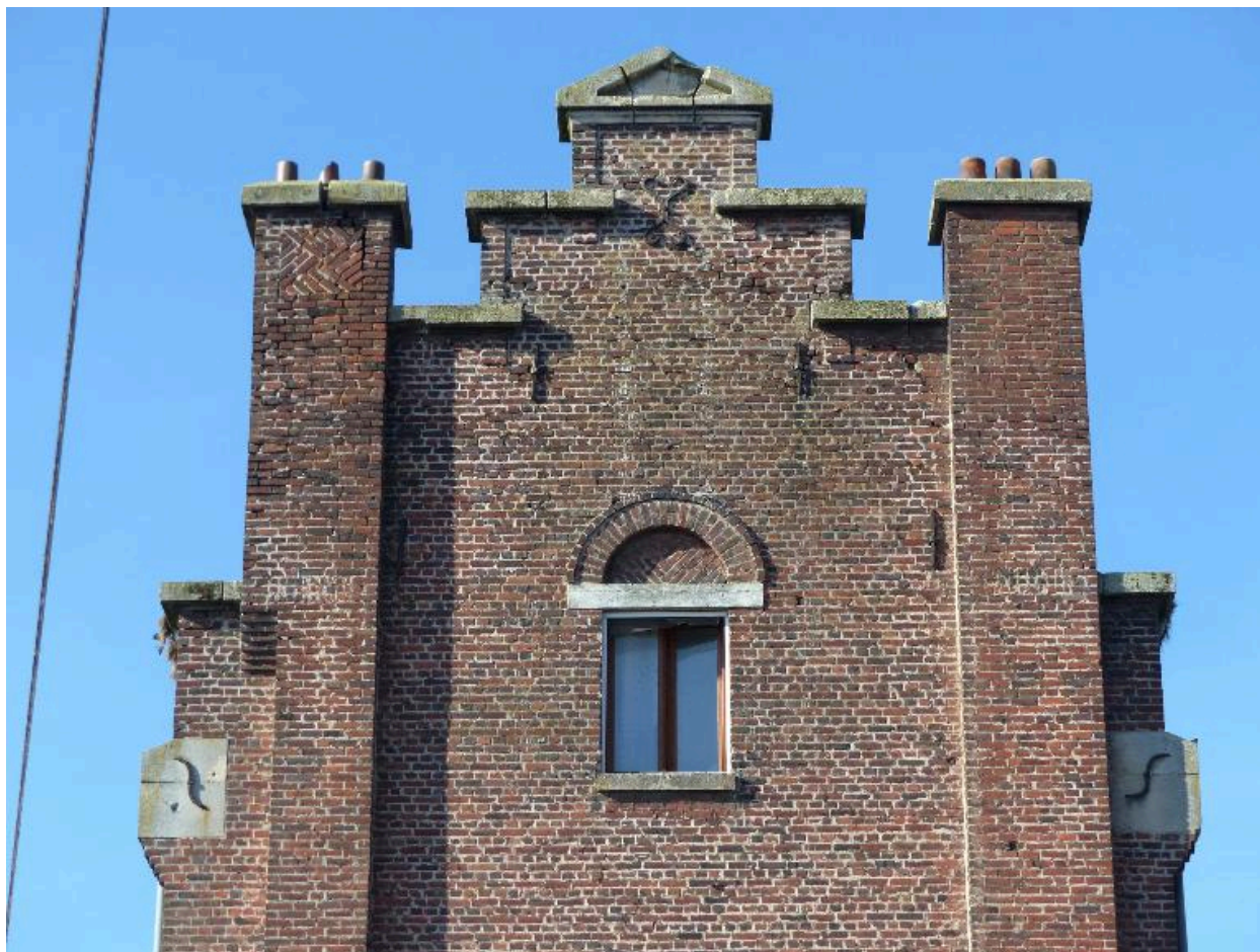
Vue du pignon est.
