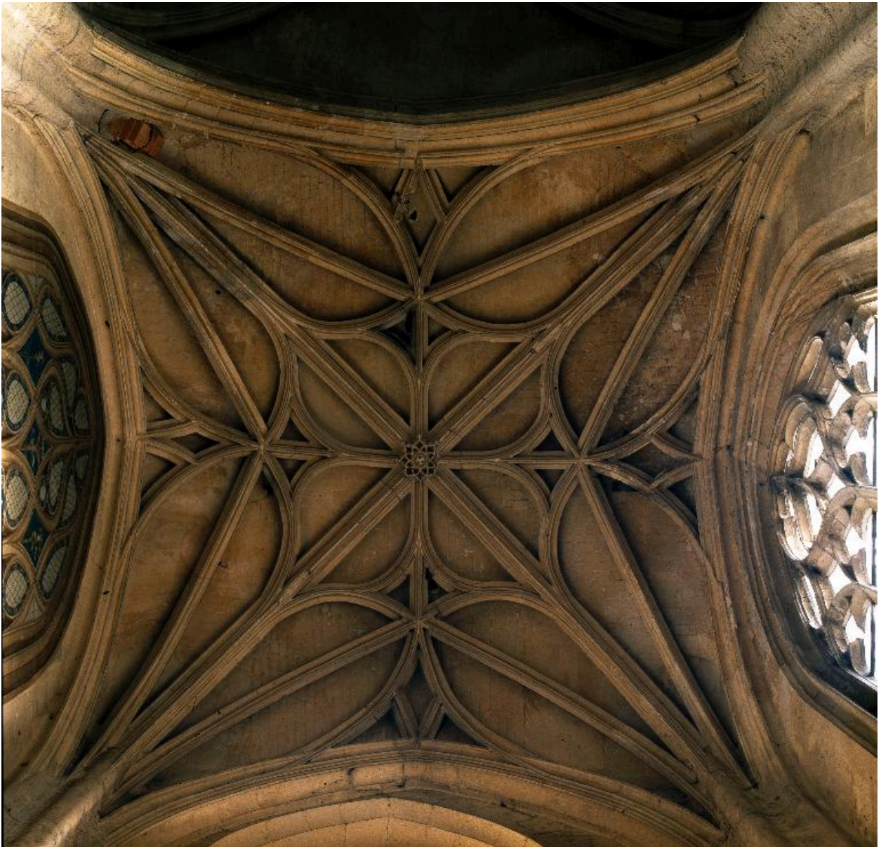
Vue d'ensemble de la voûte de la chapelle des Morts.
