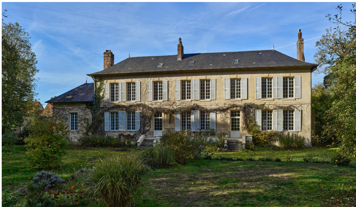
Vue générale de l'ouest de la maison de maître.
