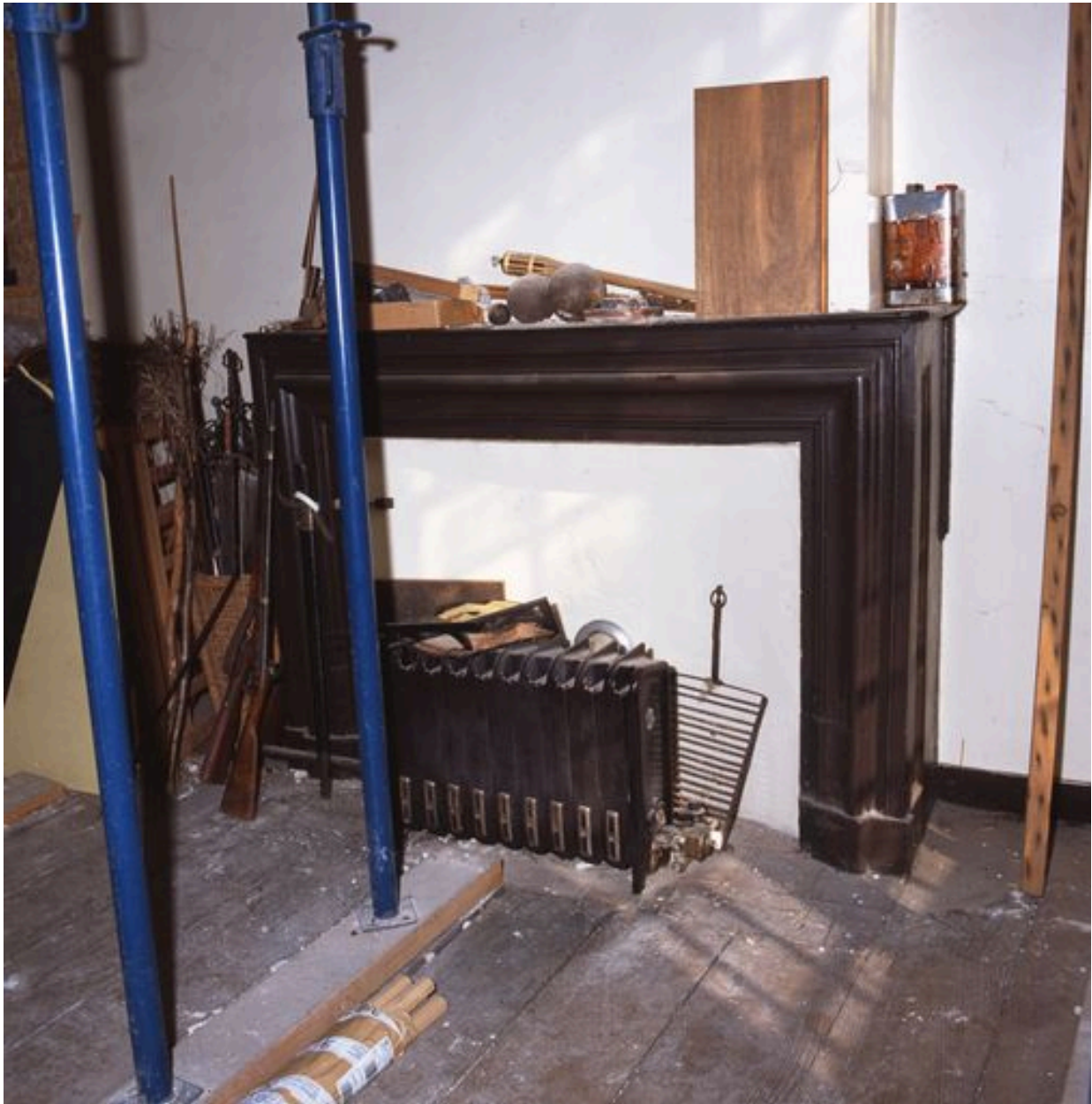
Corps de logis médiéval, intérieur, 1er étage, 2e pièce, vue partielle : étais, cheminée.
