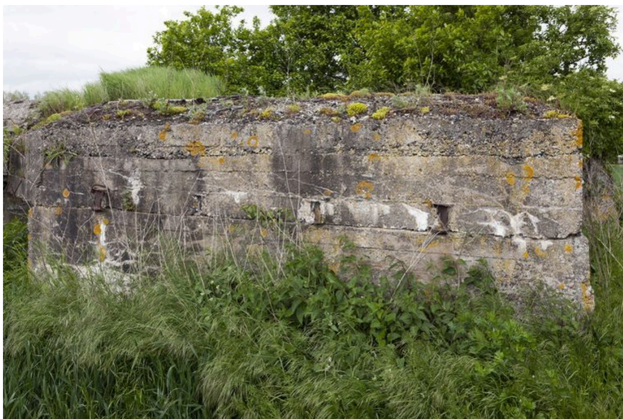
Vue latérale, vers le sud-ouest
