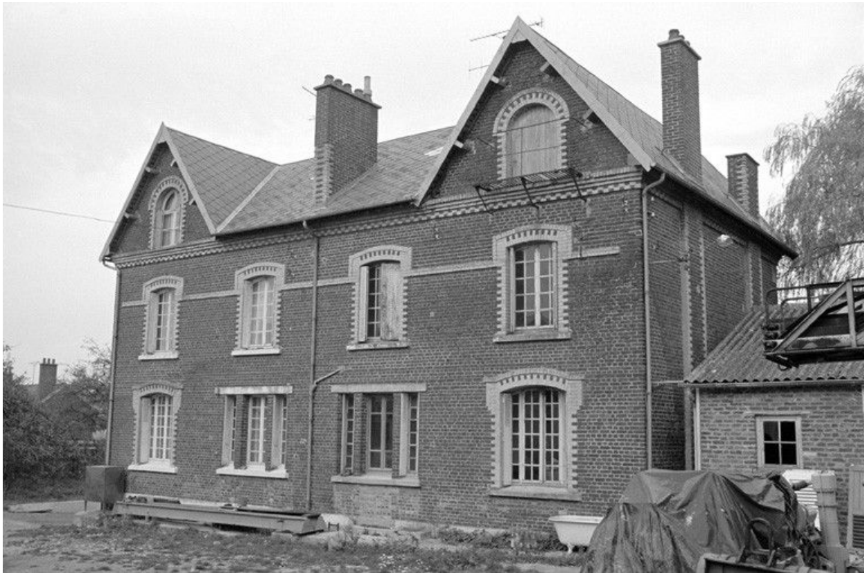
Logement patronal, élévation postérieure.
