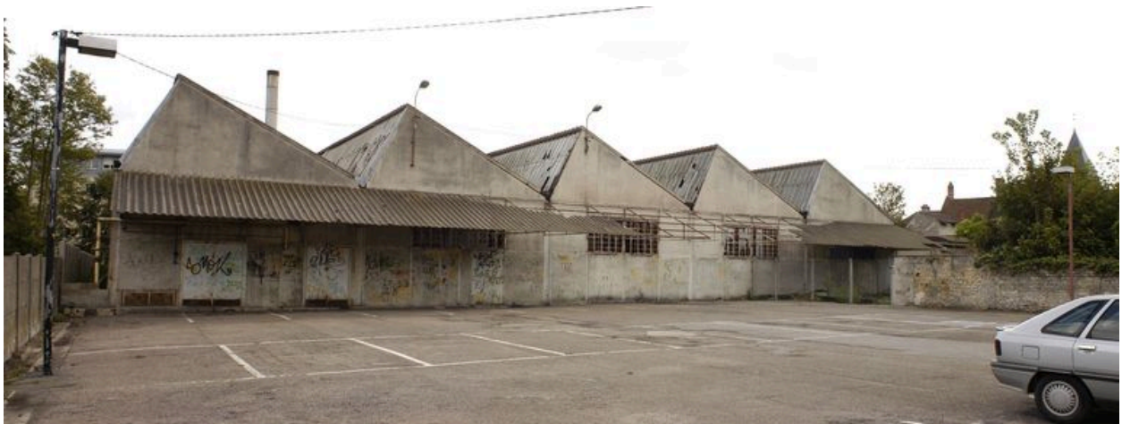
Vue générale des ateliers de fabrication en shed.
