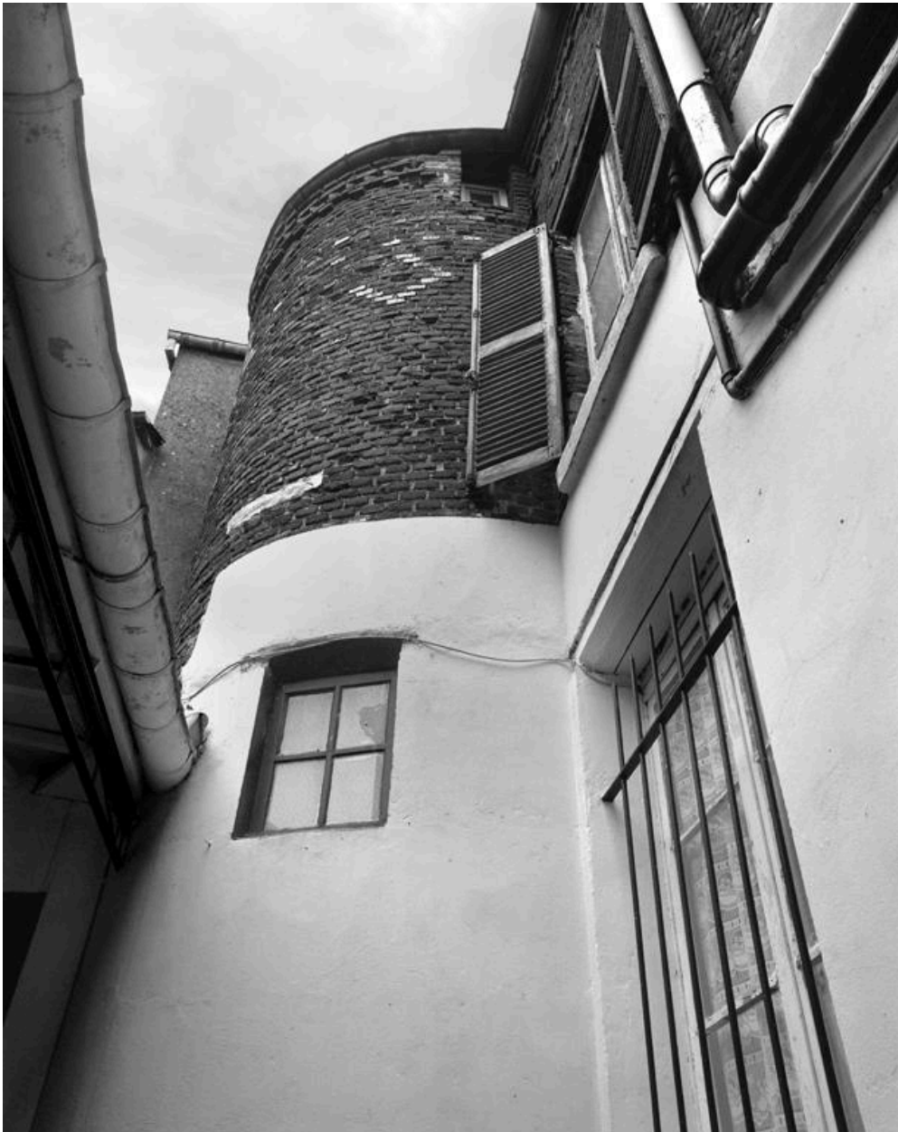
Vue extérieure de l'escalier demi-hors-oeuvre.
