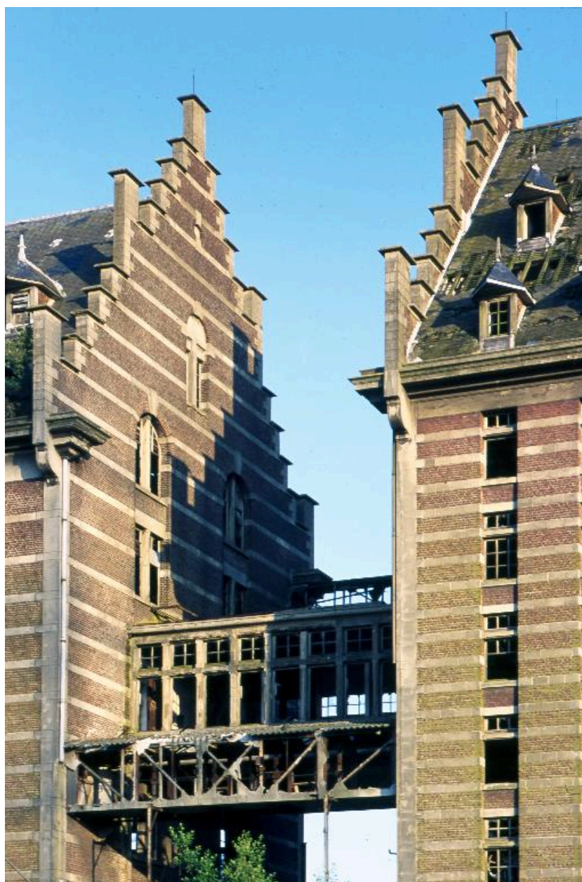
Passerelle au 3e étage reliant la salle des moteurs aux silos à farine.
