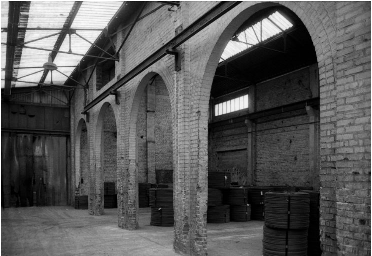
Atelier de fabrication : vue intérieure.
