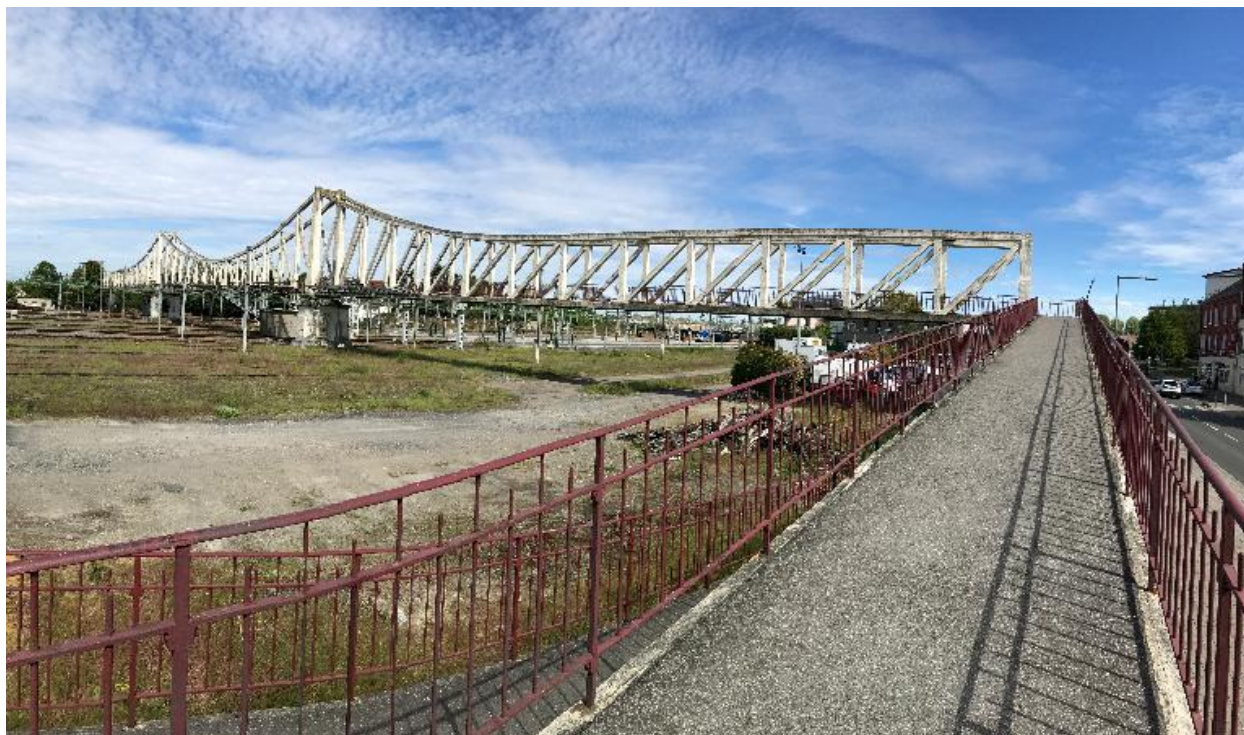
Rampe d'accès piéton à la passerelle.
