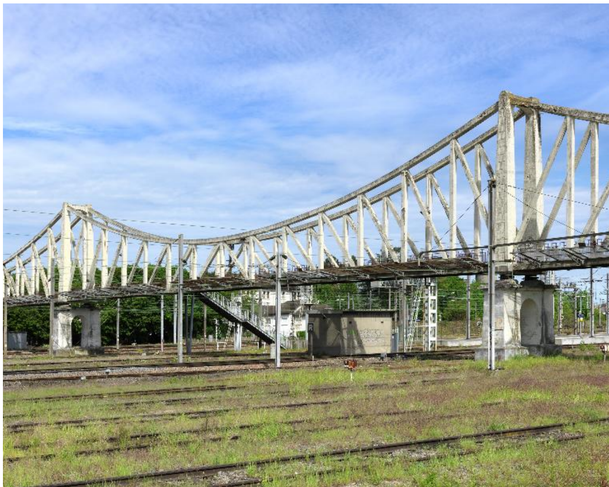
Vue du tablier central de la passerelle.
