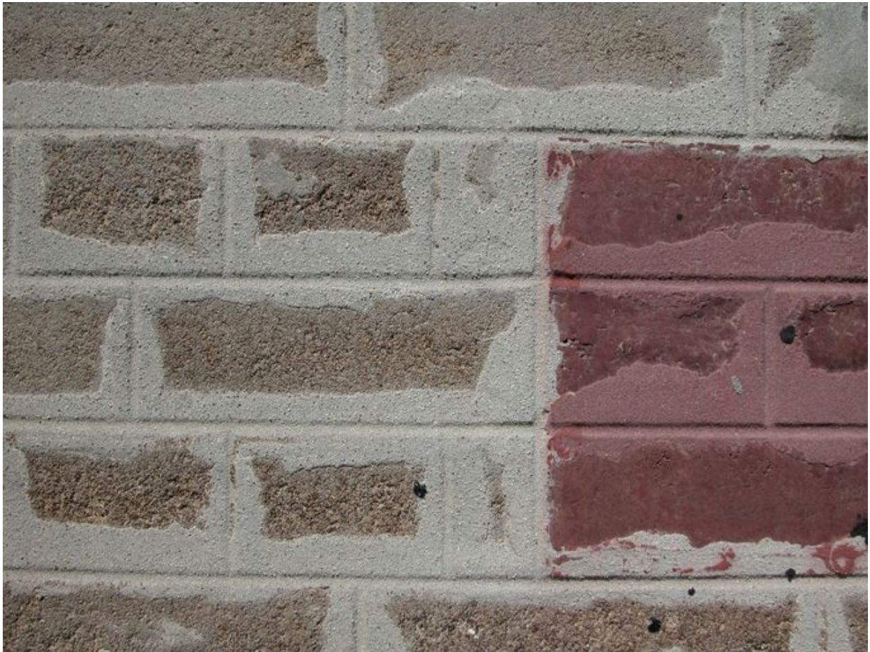
Détail de la mise en oeuvre de la façade.
