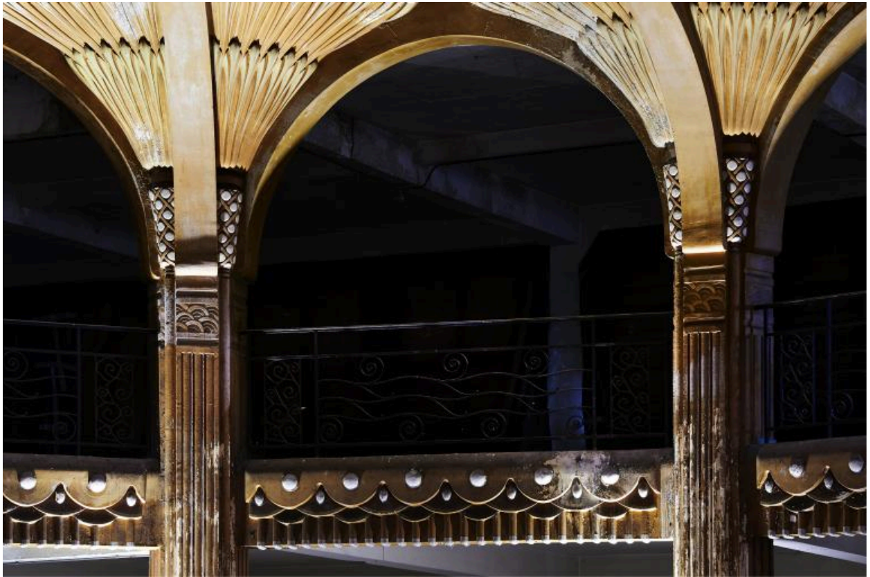
Détail d'une travée de balcon du dernier niveau de l'atrium ovale.
