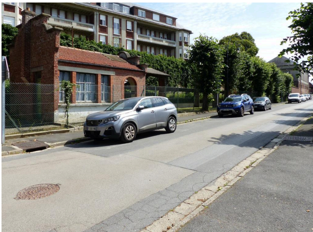
Vue de situation, depuis le boulevard.
