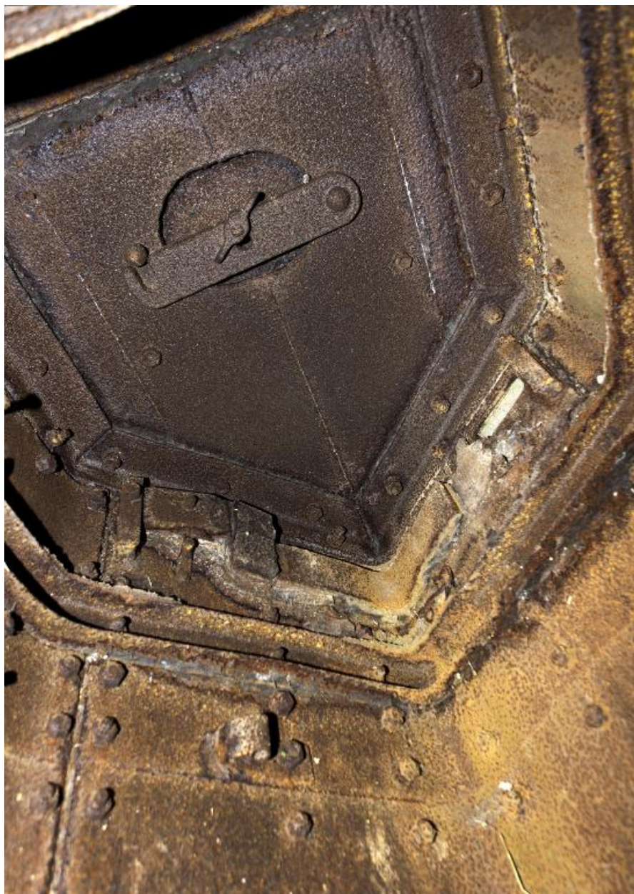
Observatoire casematé, vue intérieure du couvrement cuirassé
