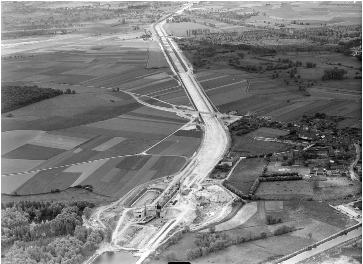
Vue aérienne du chantier dans le secteur de l'écluse n°1 de Palluel (Pas-de-Calais) en 1965. (IGN. Photothèque Nationale. 1965).
