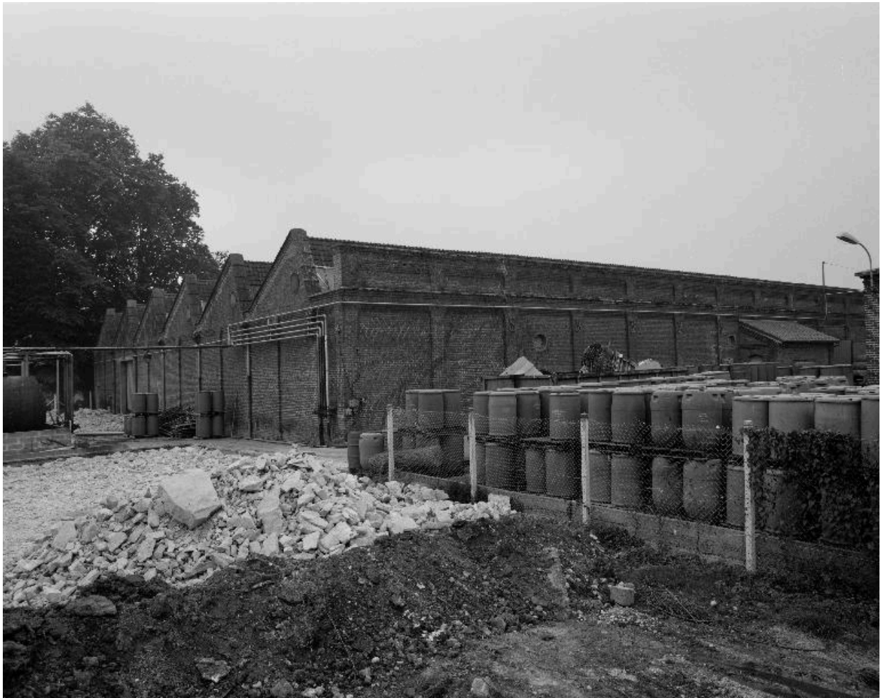
Atelier de fabrication sud, flanc nord-est.
