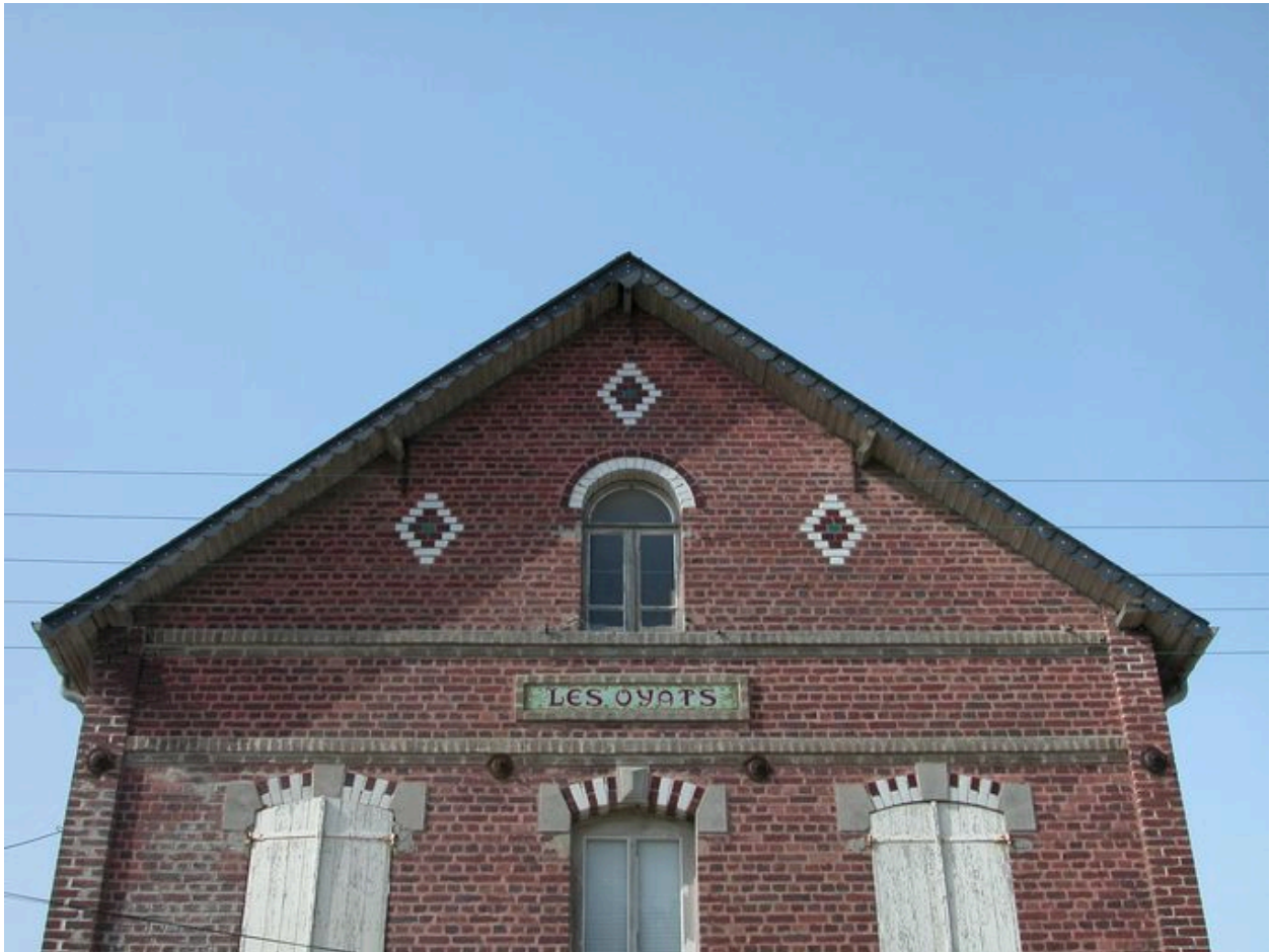
Détail du mur-pignon sur rue, avec motifs décoratifs en briques vernissées.
