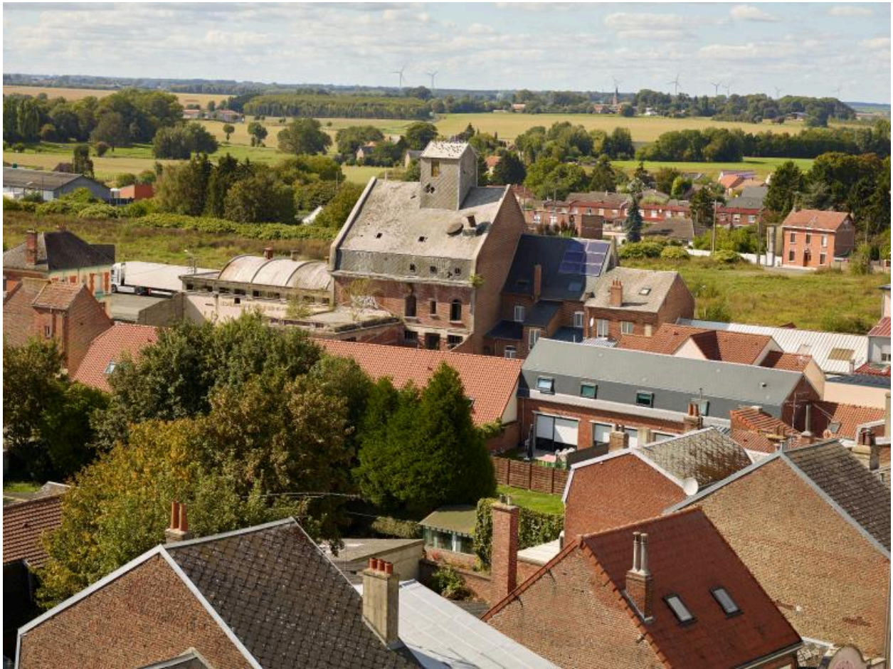
Vue de situation depuis le sud montrant la façade arrière de l'Hôtel Sheffield, après transformation en silo.
