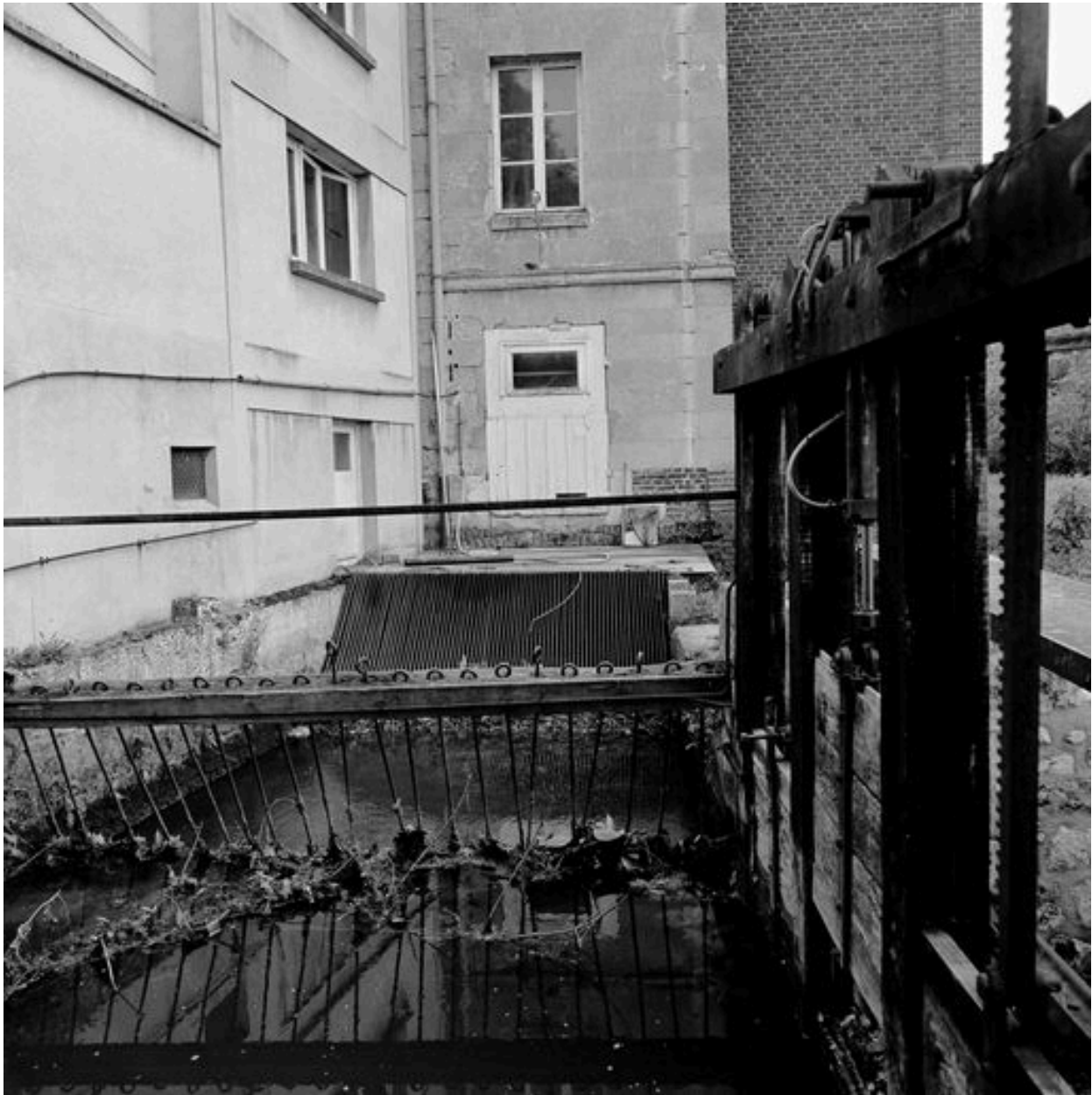
Vannes de décharge.
