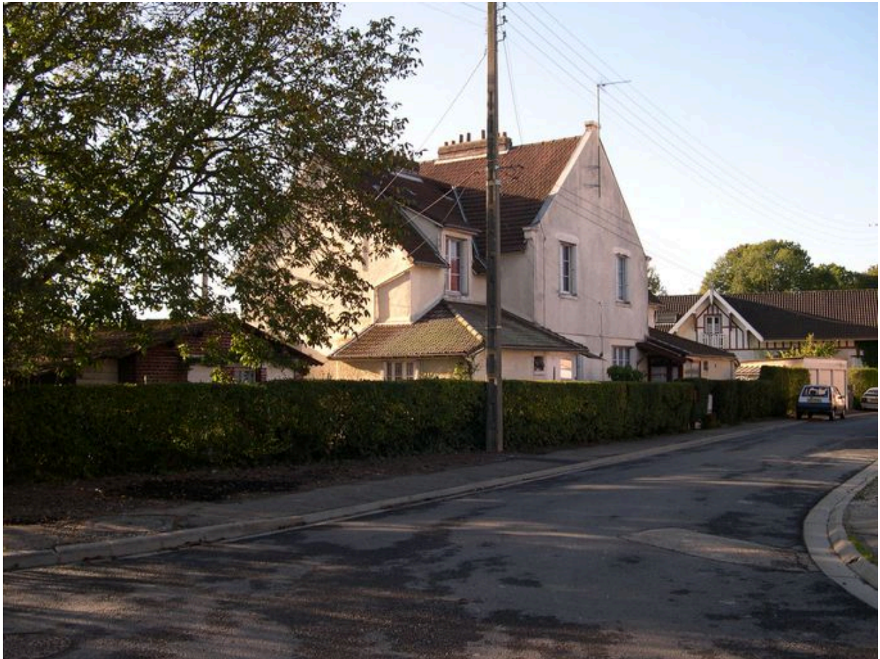
Maison à quatre unités d'habitation (4 logements de 4 pièces), 8 à 14 allée des Tilleuls. Vue prise en 2004 avant restauration.
