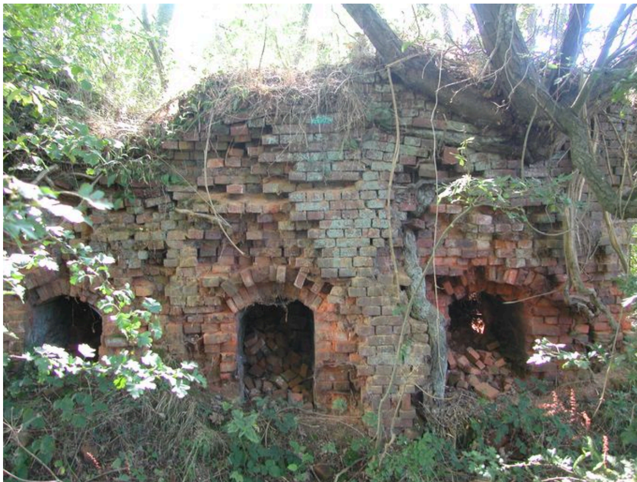
Les vestiges du four de cuisson, détail des alandiers.
