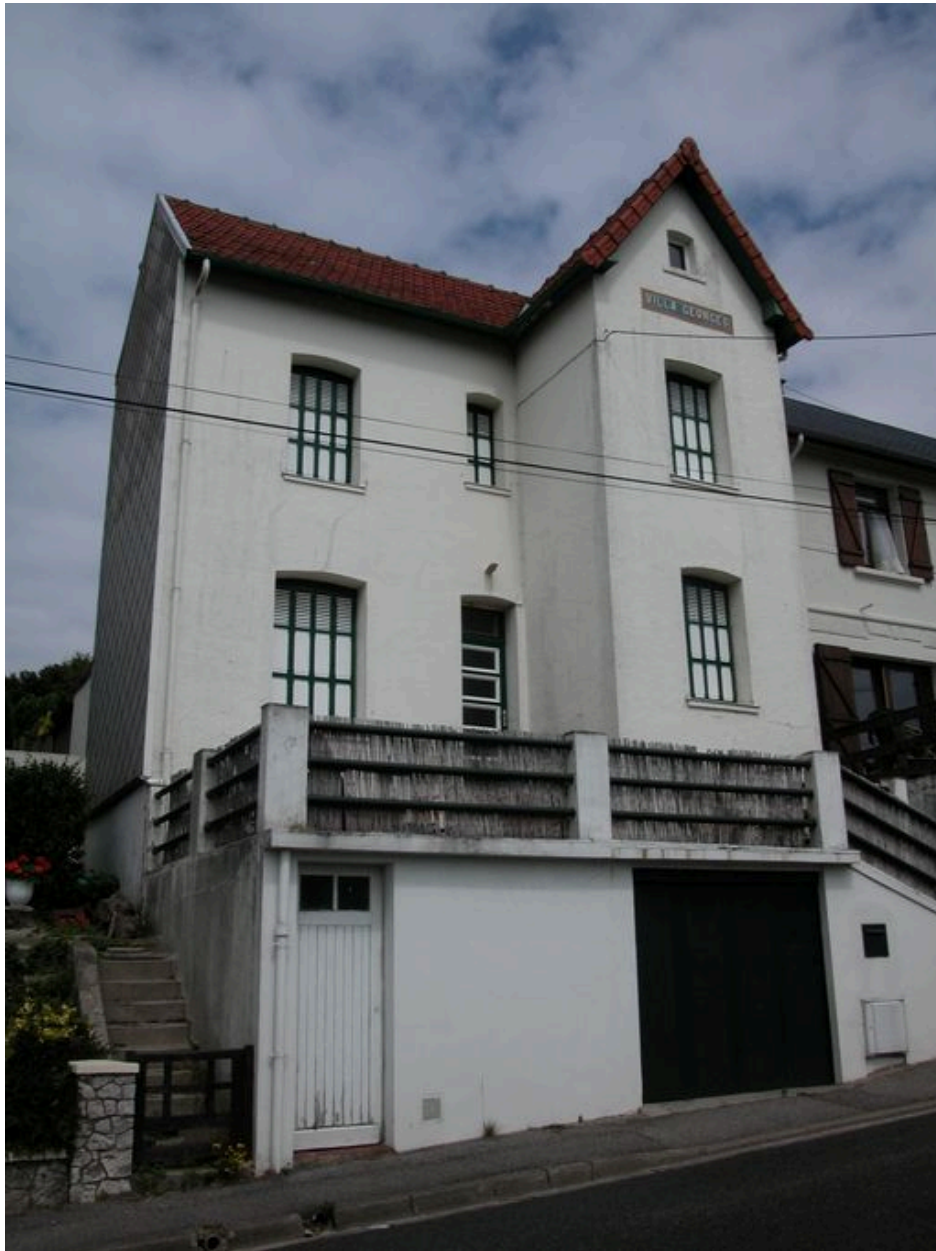
Villa Georges, 81 avenue du Général-Leclerc (1983 AD 191).
