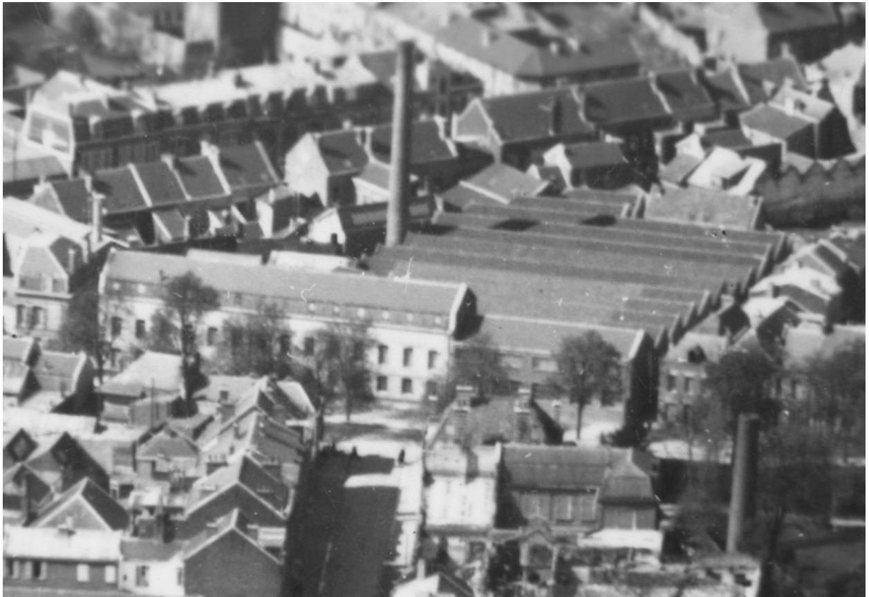
Vue du site vers 1933-1936.
