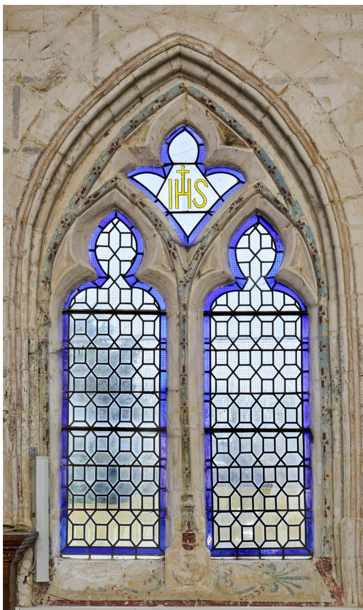
Intérieur, détail d'une des baies du chœur.
