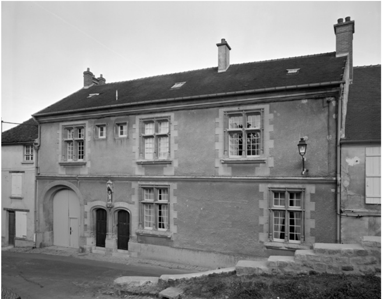
Vue générale depuis la rampe d'accès au château.
