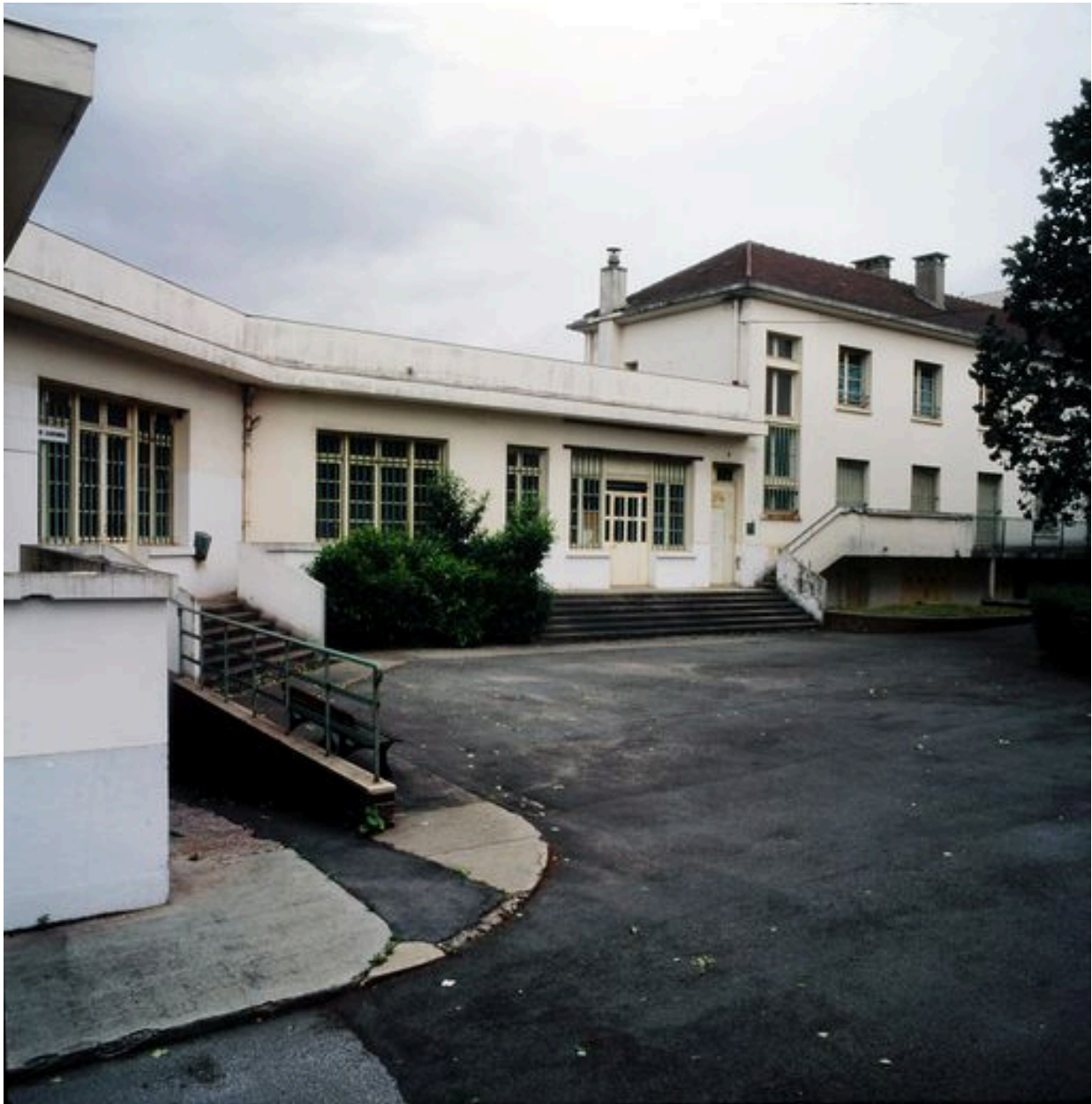
Vue des bureaux depuis la cour intérieure.
