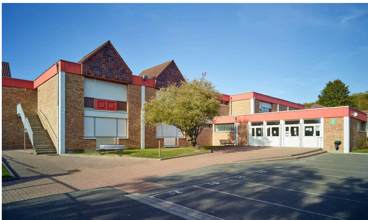
Vue depuis la cour, au sud.
