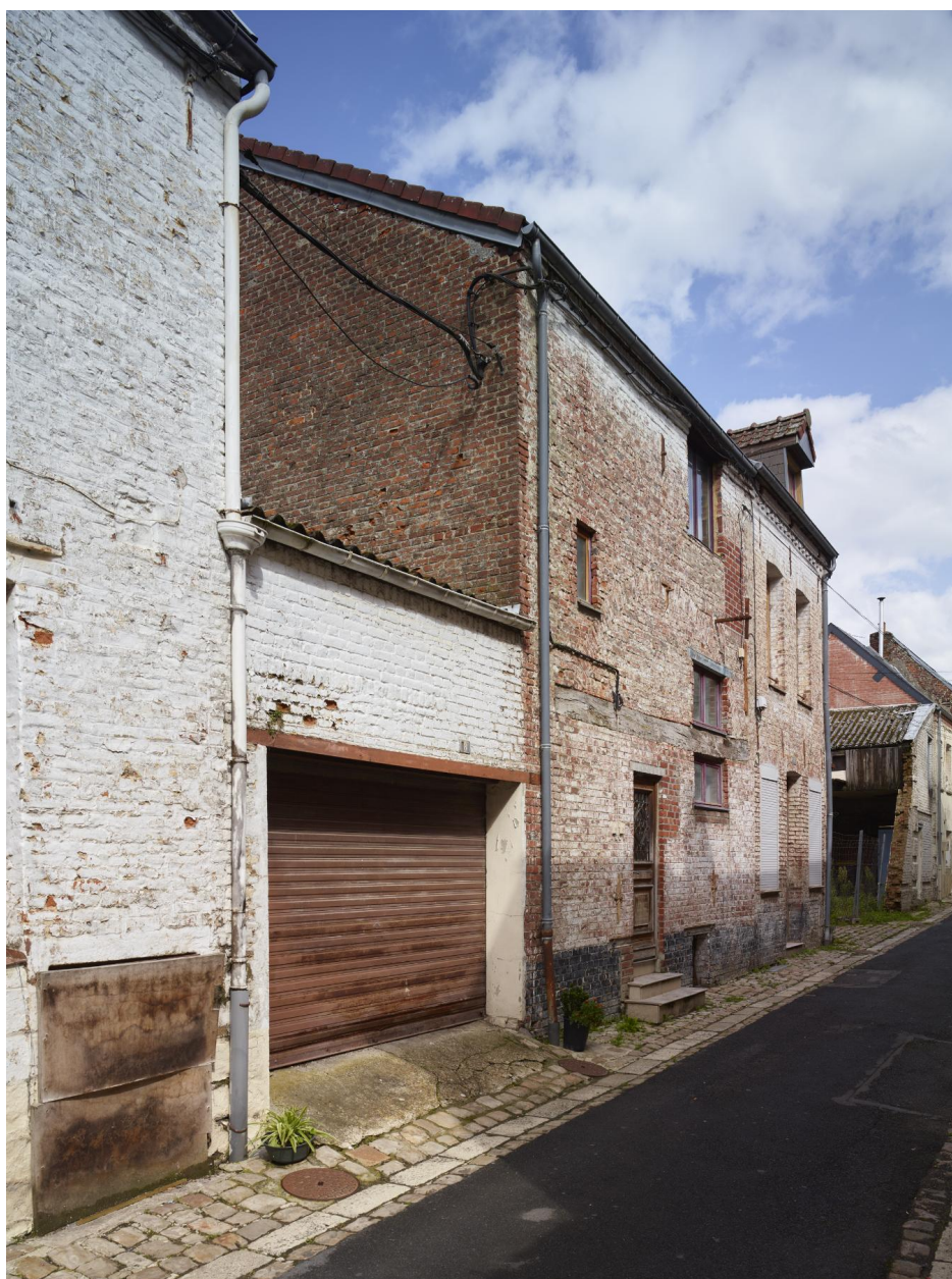
Ancienne remise, vue générale orientée ouest/est.
