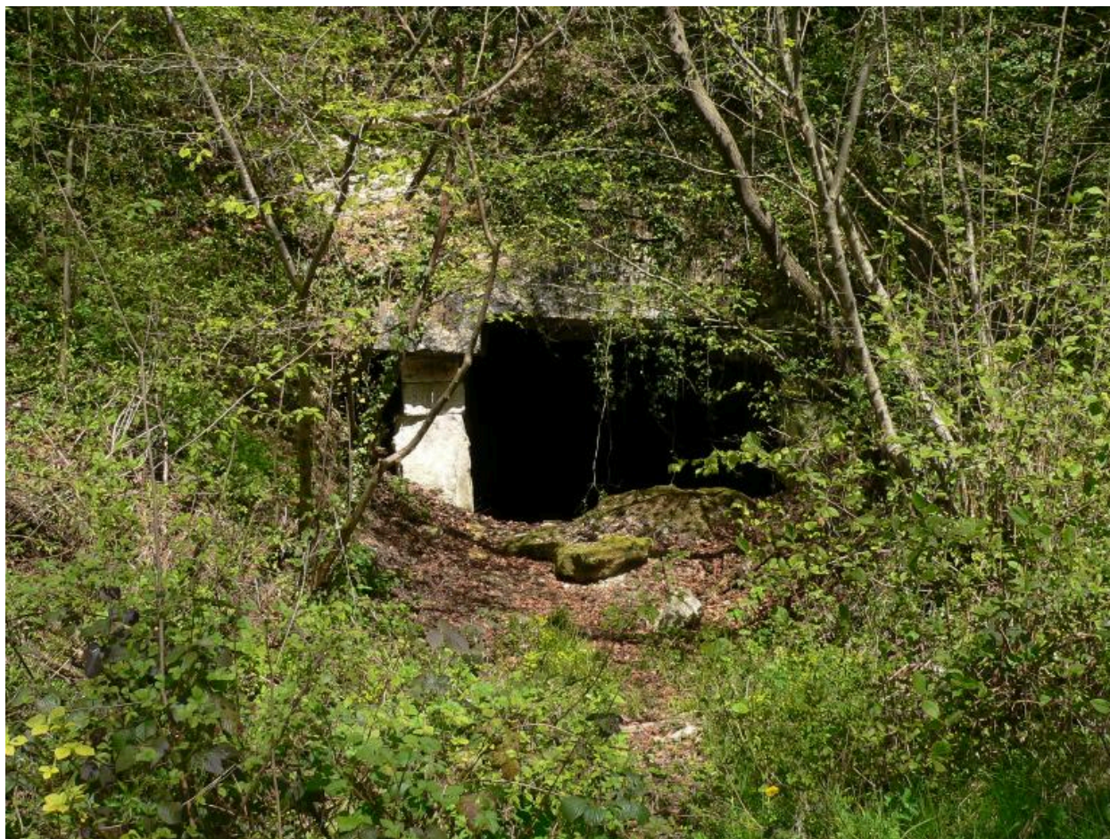
Vue de l'entrée d'une carrière, rue du Bois.
