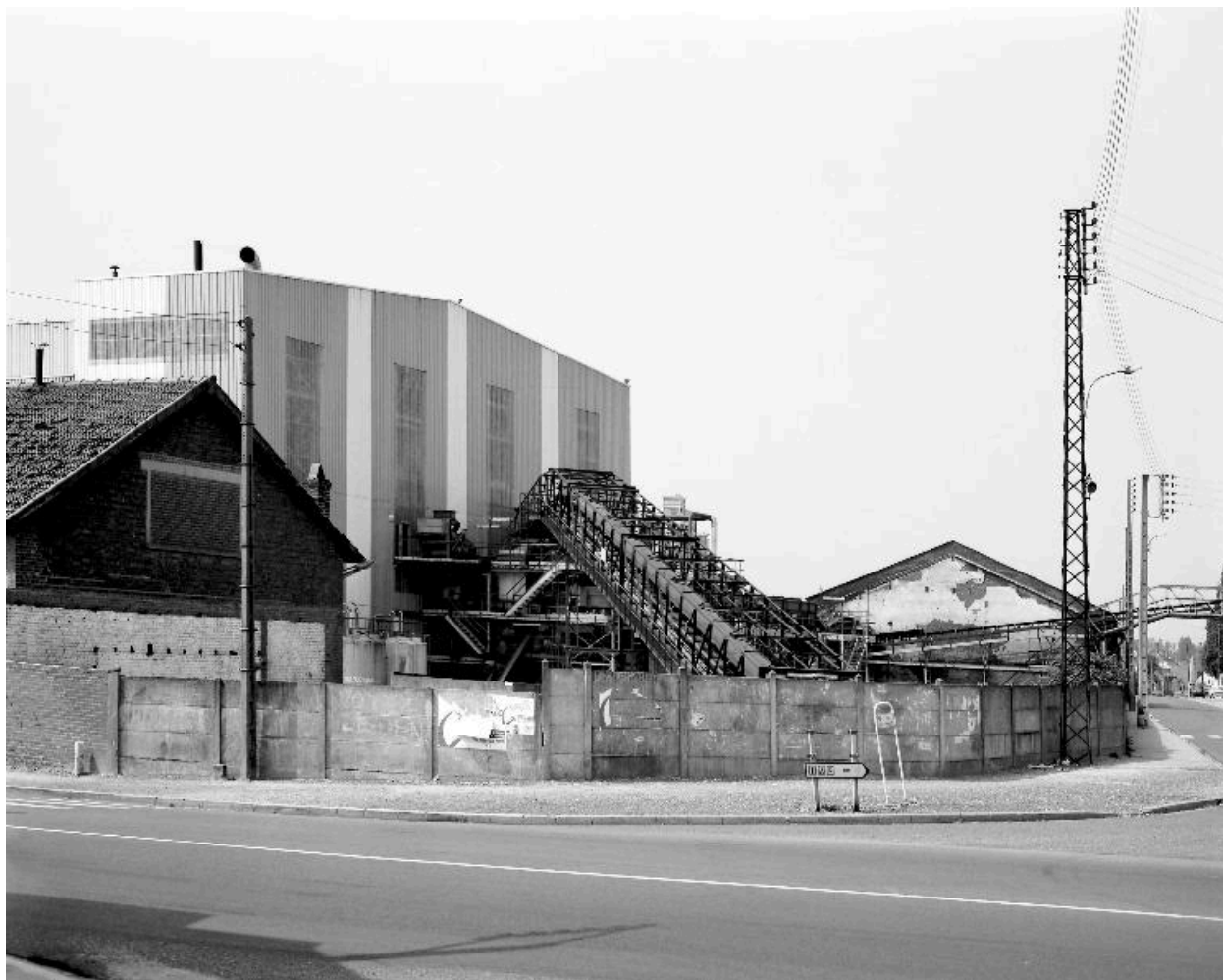
Atelier de fabrication, vue partielle, flanc nord.
