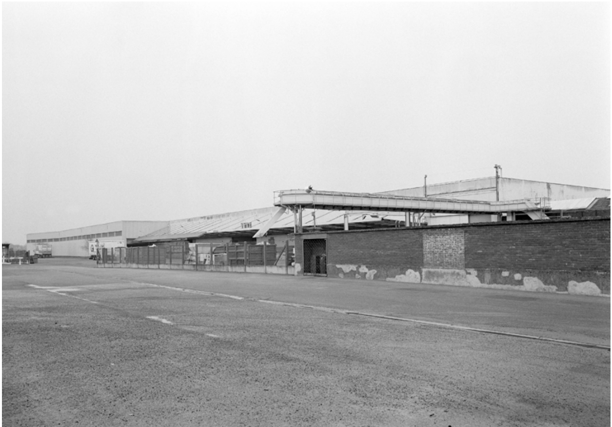
Vue de la partie sud de l'usine, occupée par les stocks.
