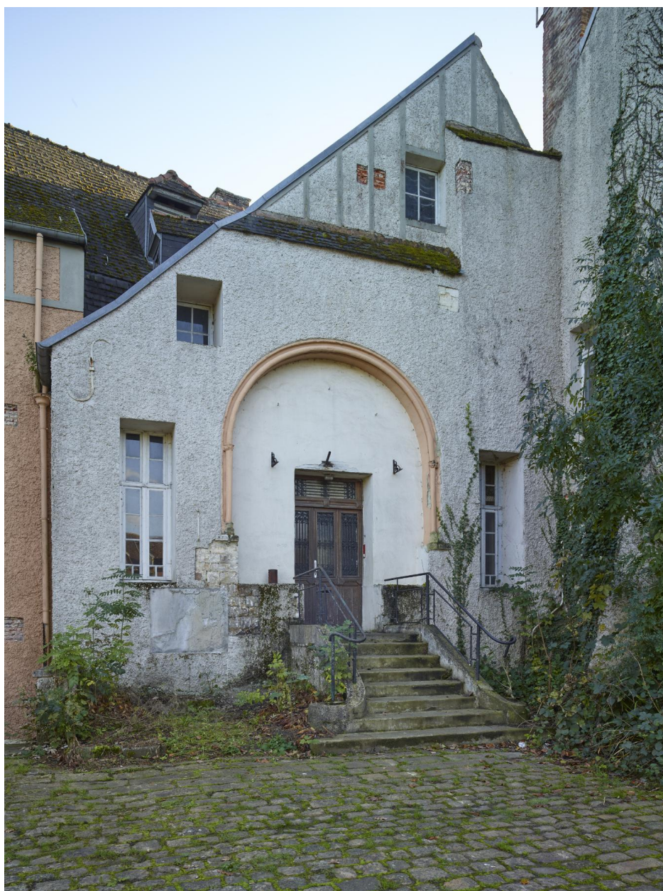
Caserne Cernay : façade avant, détail de l'arche de l'ancienne chapelle toujours visible sur le mur de l'aile est.
