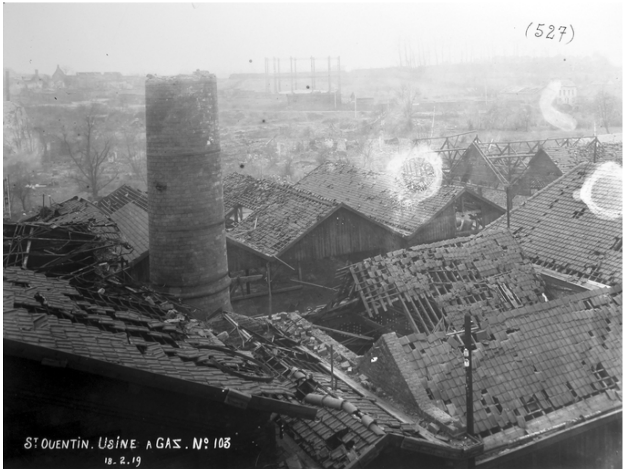
L'usine à gaz en février 1919. Au fond, le gazomètre du Vieux-Port (AD Aisne).
