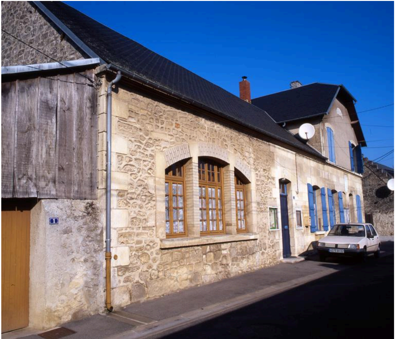
Vue générale, de trois-quarts, de la façade sur rue.
