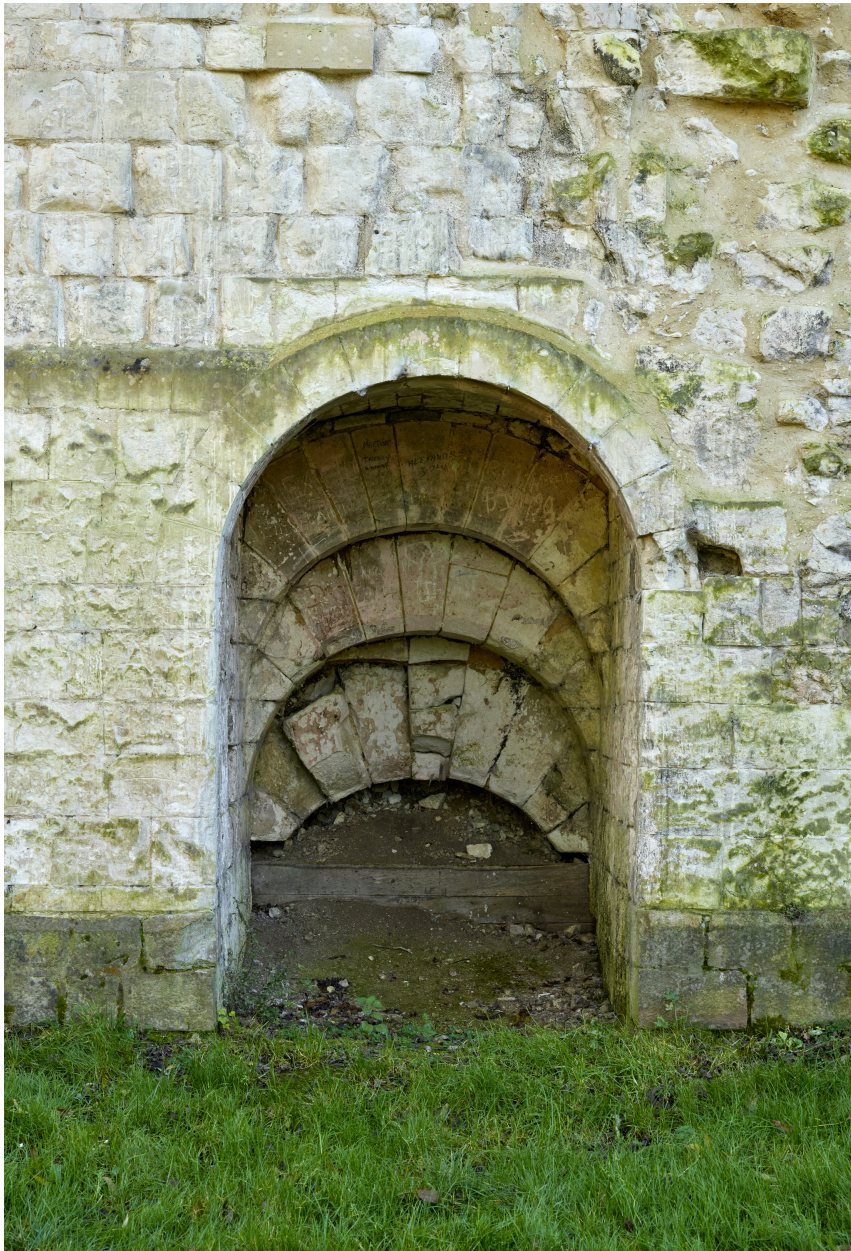
Ancienne porte et escalier, depuis le nord-est.
