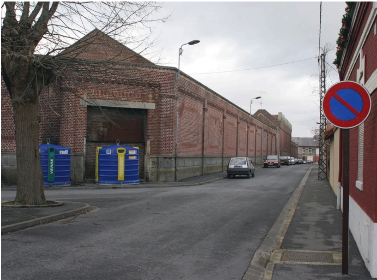
Façade de l'usine rue de la Convention.
