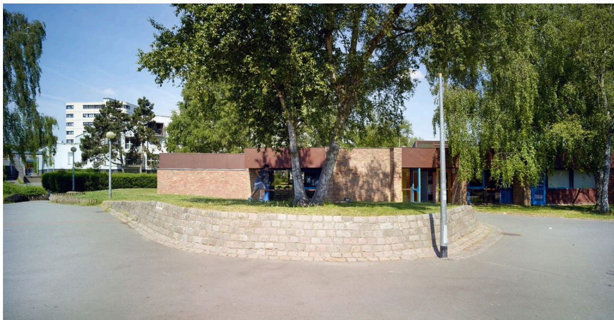
Vue du restaurant scolaire depuis le Chemin du Triolo.
