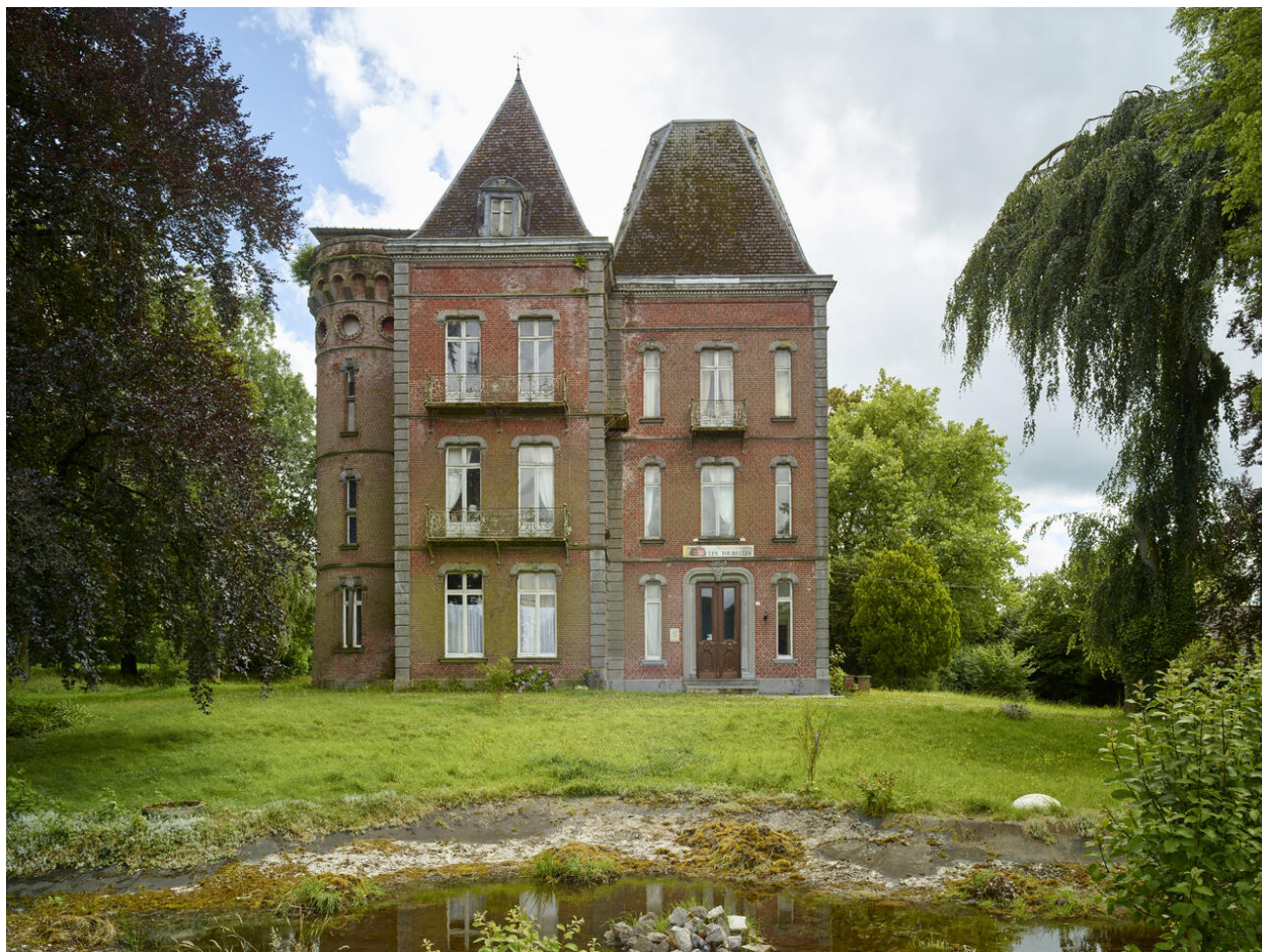
Élévation nord, depuis le parc.
